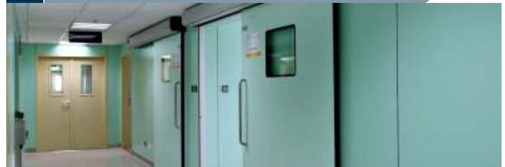
Dòng cửa chì chuyên dụng (X-rays door)
